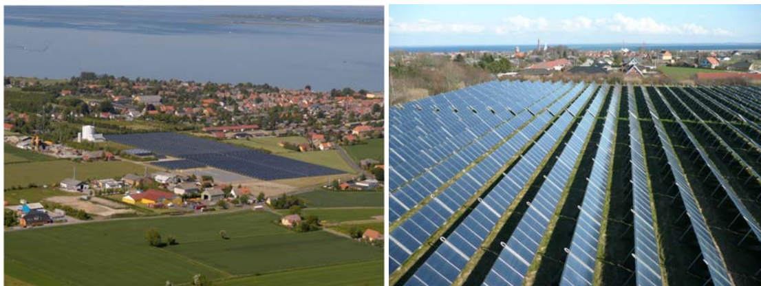
Figure 22 : Champ solaire au sol à Marstal (Danemark) – 18000 m 2 (Source : Solites)
