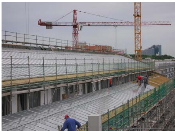
Figure 18 : Champ solaire en toiture à Munich (Allemagne) - 2900 m 2 (Source : Solites)
