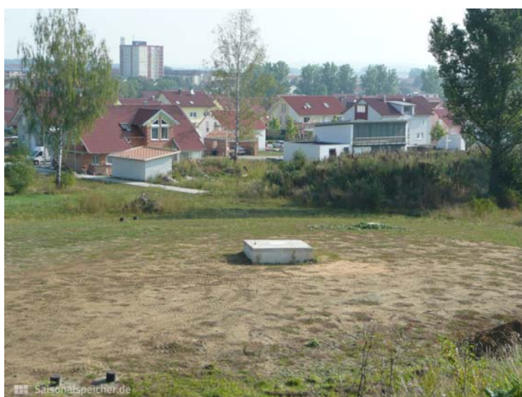
Figure 31 : Stockage en sondes géothermiques BTES à Crailsheim finalisé (Source : Solites)
