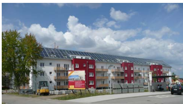
Figure 19 : Champ solaire en toiture à Crailsheim (Allemagne) - 7300 m 2 (Source : Solites)
