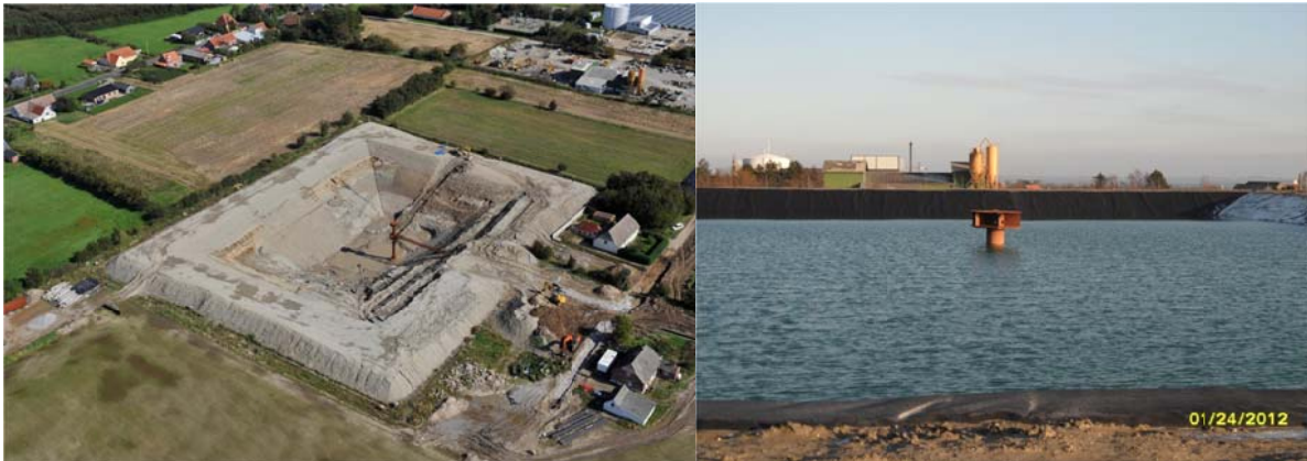
Figure 25 : Stockage en fosse PTES en construction à Marstal - 75000m 3 (Source : Solites)
